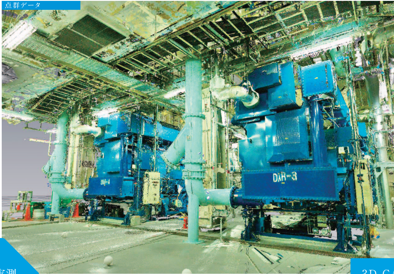
3Dレーザースキャニングによって、既存の建物・設備を無数の3D座標点(点群データ)としてデータ化します。 ▲上記の熱源機械室(約280㎡、高さ約9m)の場合、合計26カ所を約8時間で計測しました。
