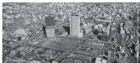
新宿副都心地域 地域冷暖房設備
