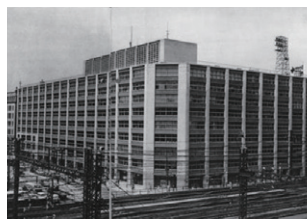
新大手町ビル 冷暖房設備
