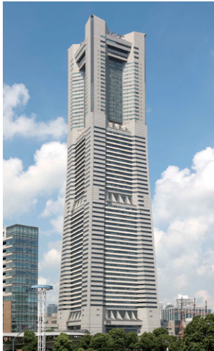
横浜ランドマークタワー 空調設備
