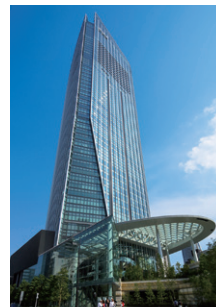
虎ノ門ヒルズ 空調設備
