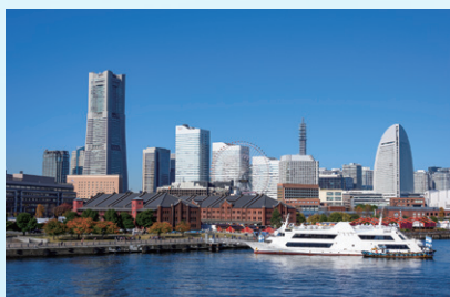
地域冷暖房設備
