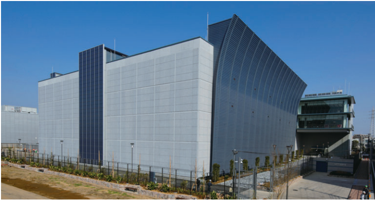
NTT DATA Mitaka Bldg. EAST (Mitaka City, Tokyo)
