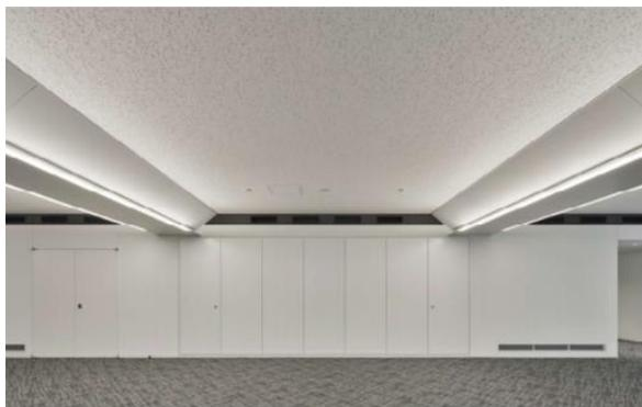
上) 変風量コアンダ空調システム…壁面上部より空気を送り出す。天井は空気を這わせるため、平滑な仕上げになっている。
