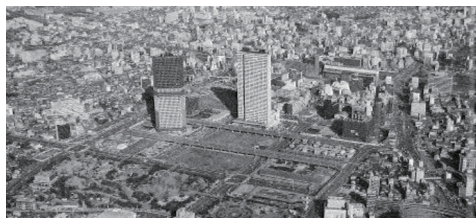
新宿副都心地域 地域冷暖房設備
