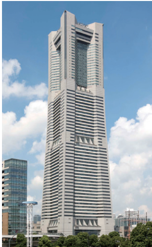
横浜ランドマークタワー 空調設備
