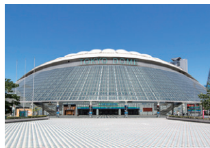
東京ドーム 空調設備
