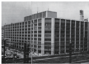
新大手町ビル 冷暖房設備
