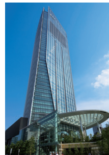
虎ノ門ヒルズ 空調設備
