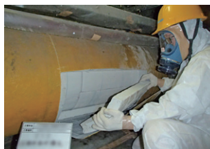
石綿含有配管保温材の撤去
