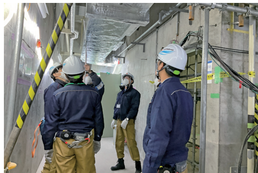
ダクト施工状況の確認
