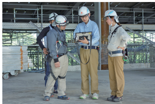
ICTツールを用いた施工状況の確認
