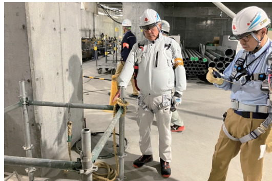
安全衛生協議会パトロール
