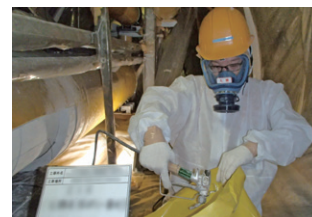
石綿飛散防止剤を噴霧して廃棄
