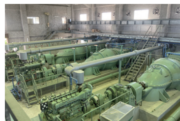
原動機更新工事中の天狗鼻排水機場
