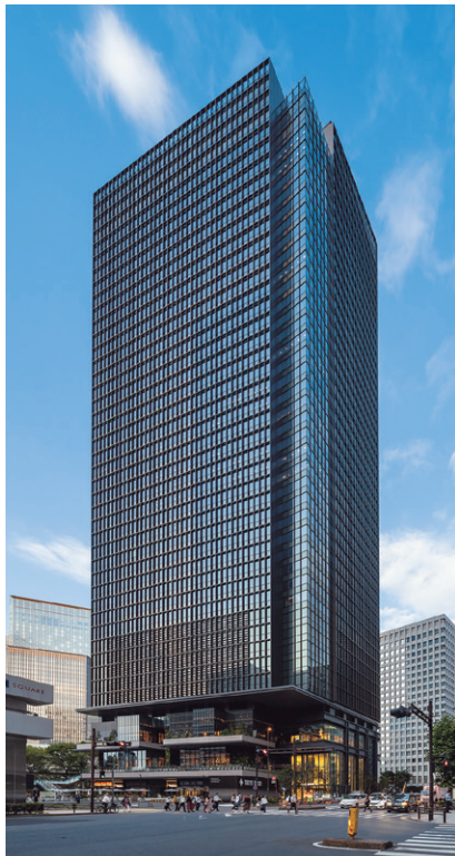
常盤橋タワー (東京都千代田区)
