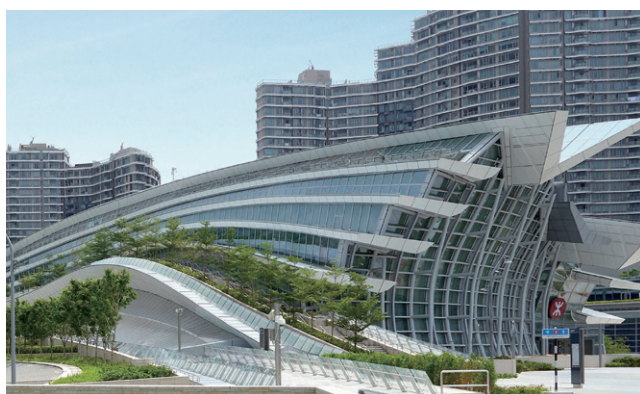
広深港高速鉄道 香港西九龍駅 (香港)
