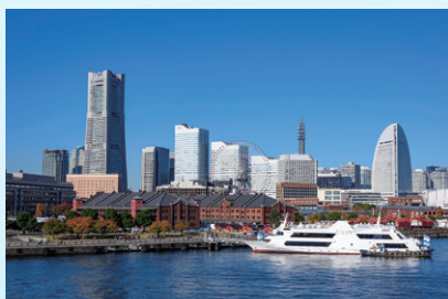
地域冷暖房設備
