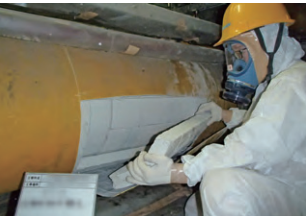
石綿含有配管保温材の撤去
