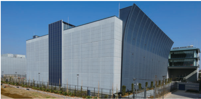
NTT DATA Mitaka Bldg. EAST (Mitaka City, Tokyo)
