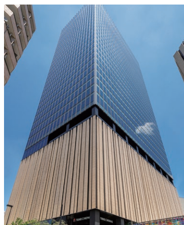
Hareza Tower (ハレザタワー) (東京都豊島区)
