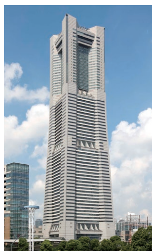
横浜ランドマークタワー 空調設備
