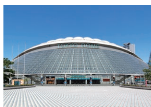
東京ドーム 空調設備
