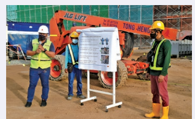
施工現場での安全衛生トレーニング
