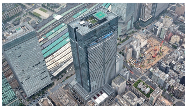
東京ミッドタウン八重洲(エネルギーセンター設置場所)
