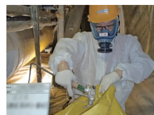
石綿飛散防止剤を噴霧して廃棄
