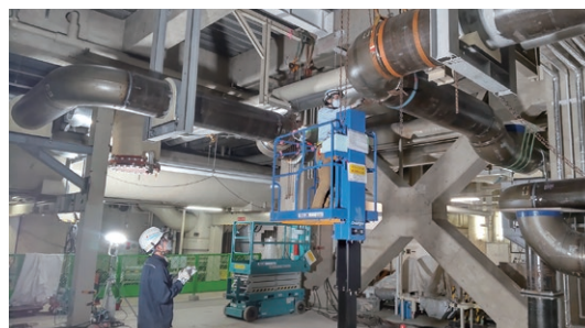
品質パトロールによる配管溶接箇所の確認
