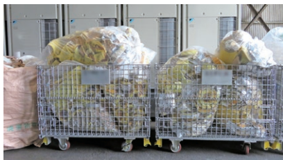
グラスウール廃材の搬出前の状況
