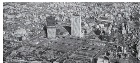
新宿副都心地域 地域冷暖房設備
