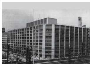
新大手町ビル 冷暖房設備
