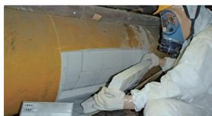
石綿含有配管保温材の撤去
