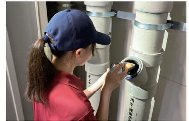
試験治具を使った配管の通水試験
