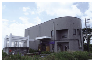
宮城県名取市 関上雨水ポンプ場災害復旧工事
