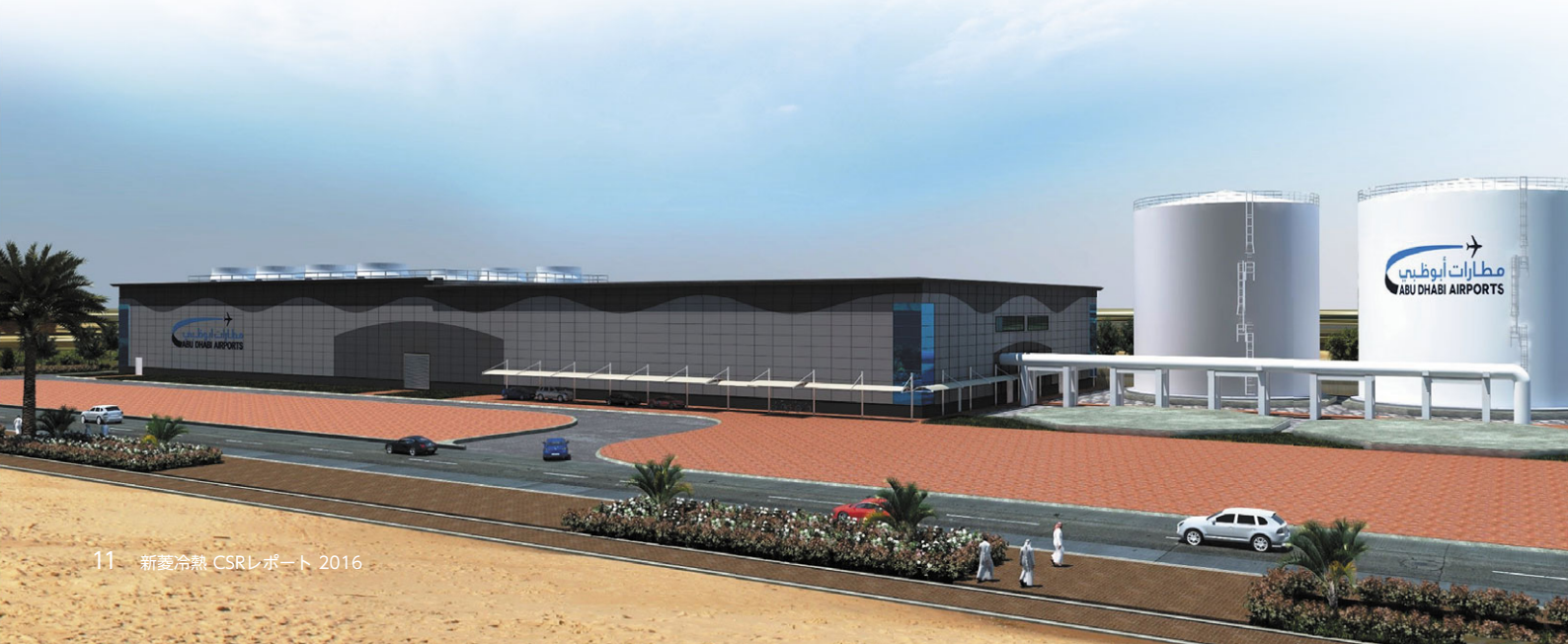
アブダビ国際空港新ターミナル向け地域冷房プラント
