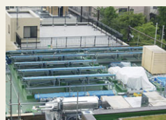
ソーラークーリングシステム工事
