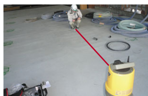
3D-MAPSによるレーザー照射 ※写真のレーザー光はイメージ
