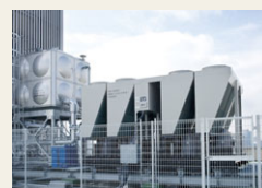
高効率空冷ターボ ヒートポンプチラー工事
