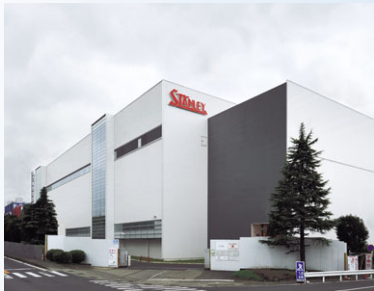
スタンレー電気株式会社秦野製作所1号館 (神奈川県秦野市)
