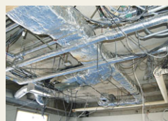
解体工事開始
