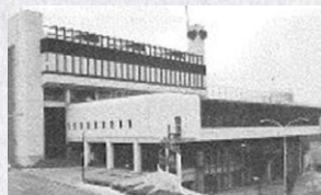
千里ニュータウン中央地区センター・地域冷暖房
