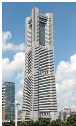
横浜ランドマークタワー 空調設備
