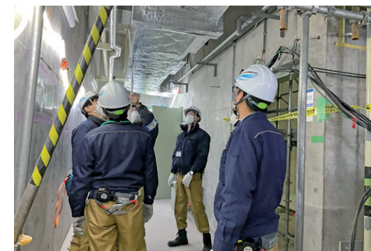
ダクト施工状況の確認
