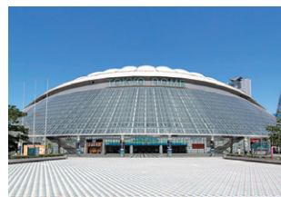
東京ドーム 空調設備
