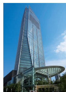
虎ノ門ヒルズ 空調設備
