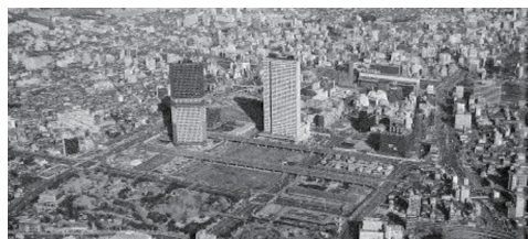
新宿副都心地域 地域冷暖房設備
