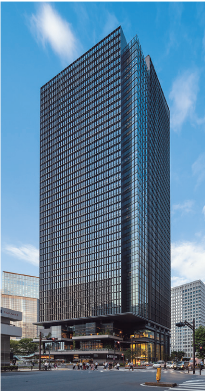
常盤橋タワー (東京都千代田区)
