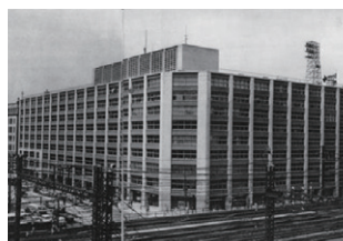
新大手町ビル 冷暖房設備
