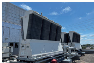
保全作業を行っているモジュールチラー
