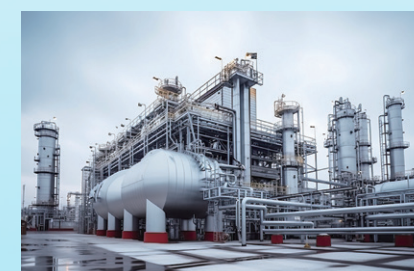
プラント設備
