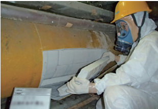
石綿含有配管保温材の撤去
