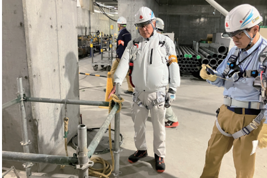
安全衛生協議会パトロール
