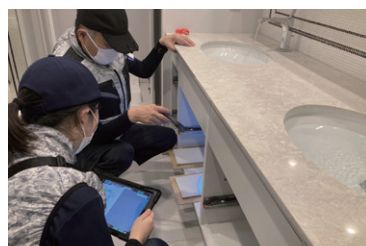
現場管理ソフトを活用した品質検査
