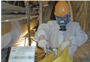
石綿飛散防止剤を噴霧して廃棄
