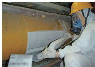
石綿含有配管保温材の撤去
