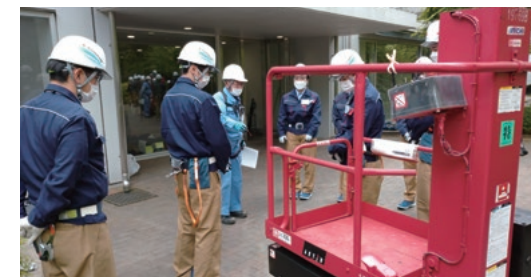
高所作業車の講習
