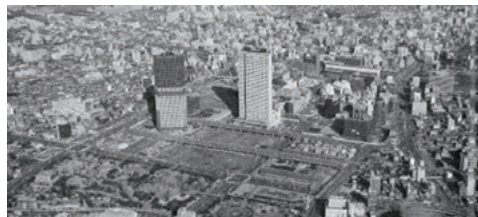
新宿副都心地域 地域冷暖房設備
