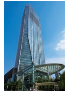
虎ノ門ヒルズ 空調設備
