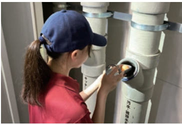
試験治具を使った配管の通水試験
