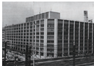
新大手町ビル 冷暖房設備
