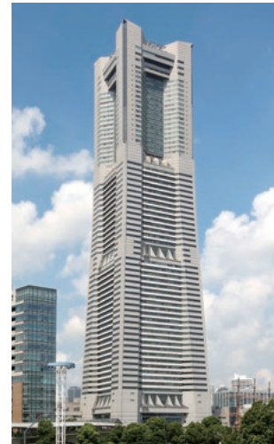
横浜ランドマークタワー 空調設備
