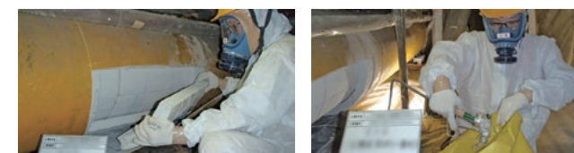
石綿含有配管保温材の撤去
