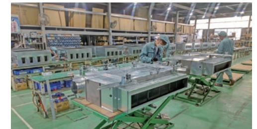
協会社工場でのユニット製作
