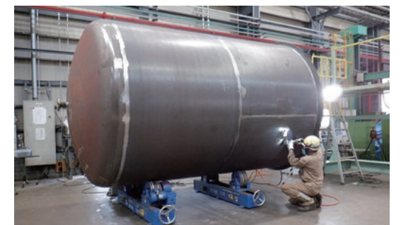
高浜工場での溶接作業
