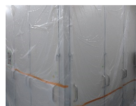
図2 目張りした脱着式パネル
